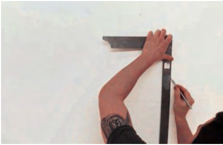
1. Einbauöffnung anzeichnen Mit einem rechtwinkligen Lineal.
