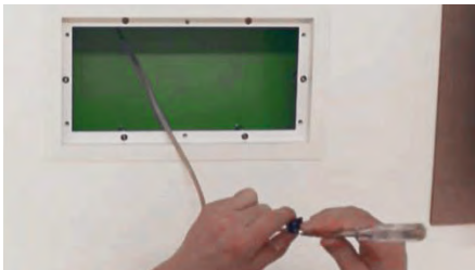
7. Stecker montieren Das verlegte Lautsprecherkabel abisolieren und die mitgelieferten Systemklemmen befestigen. AUF RICHTIGE POLARITÄT ACHTEN!
