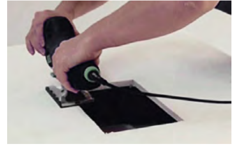
3. Einbauöffnung ausschneiden Mit der Stichsäge von Ecke zu Ecke sägen. Sorgfältig und sauber arbeiten.
