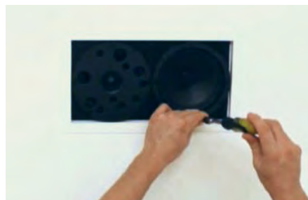
2. Haltemagnete einstellen Bei Bedarf kann die Höhe der Haltemagnete mit einem Innensechskant-Schlüssel nachjustiert werden.
