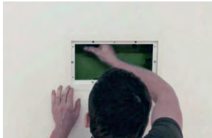
5. Rahmen einsetzen und Klemmfüße nach außen drehen
