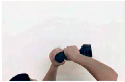
2. Einbauöffnung erstellen Mit einem Bohrer Löcher in die Ecken bohren um einen Einstieg für die Stichsäge zu bekommen zu bekommen
