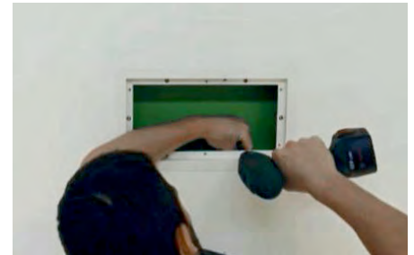
6. Klemmfüße auf Spannung festschrauben Klemmfuß festhalten und von vorne durch den Rahmen die Klemmschrauben vorsichtig mit Akkuschrauber fest ziehen.
