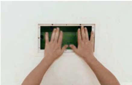
4. Einbauöffnung kontrollieren Bei zu kleiner Öffnung besteht die Gefahr, dass die Decke beschädigt wird. Bei zu großer Öffnung ist der nötige Halt des Lautsprecher nicht gewährleistet. Toleranz +/- 1 mm
